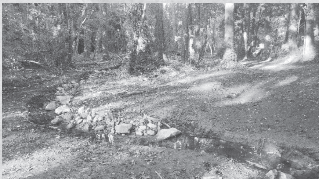
Cours d'eau après travaux (juillet 2026).
